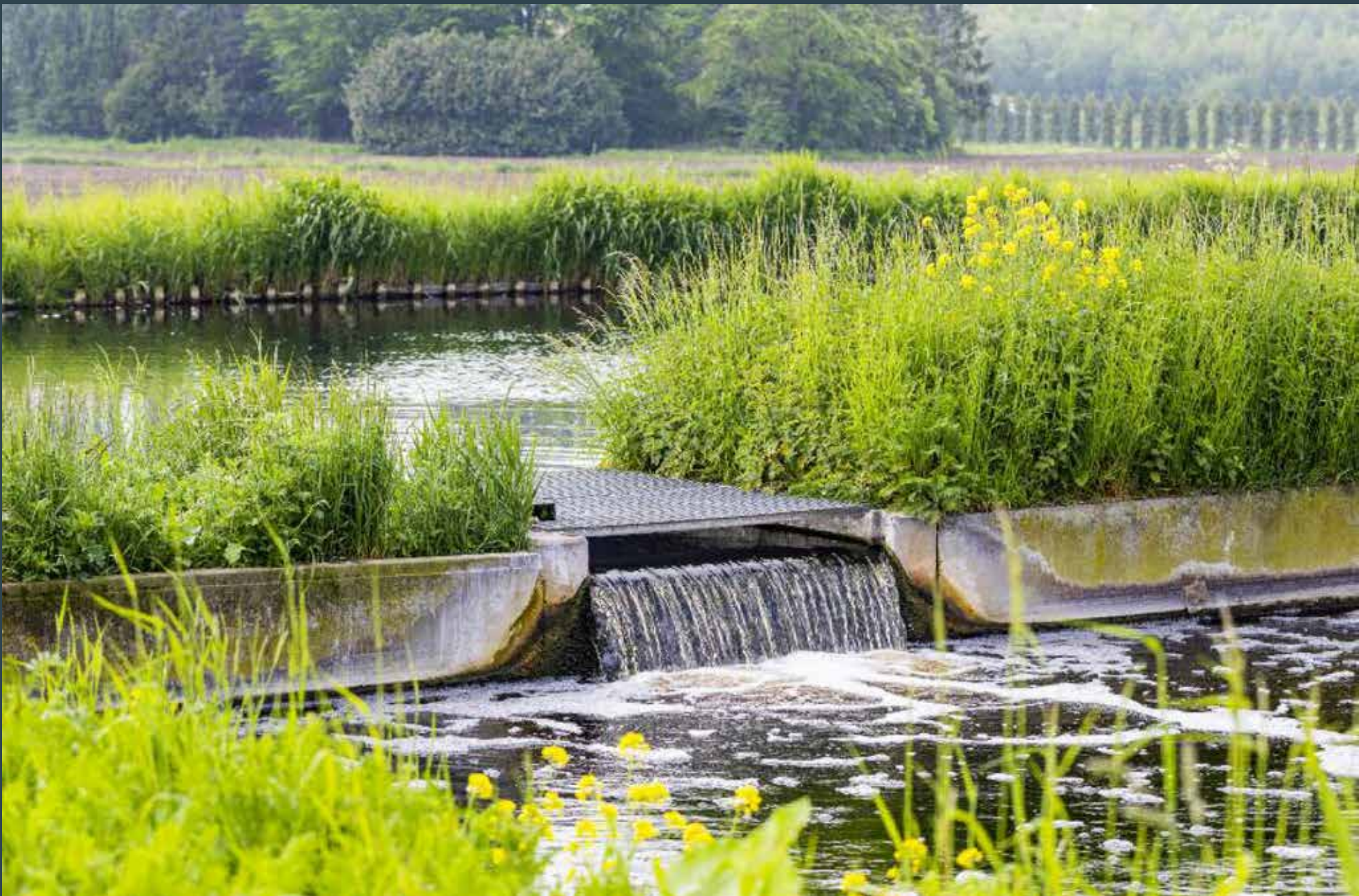
Stuw in het Boer Bier Water project.
