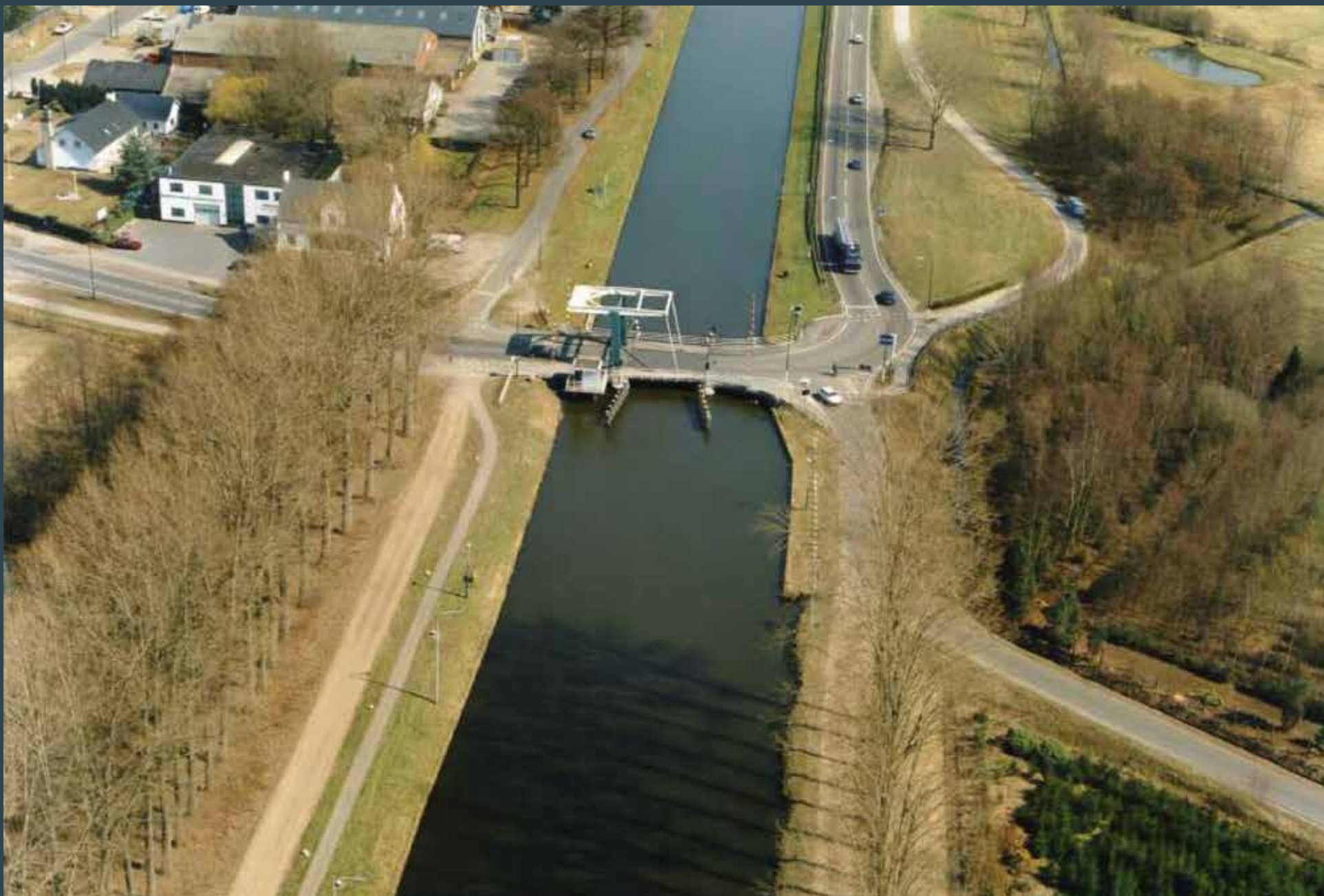
Brug bij de Oranjelaan.
