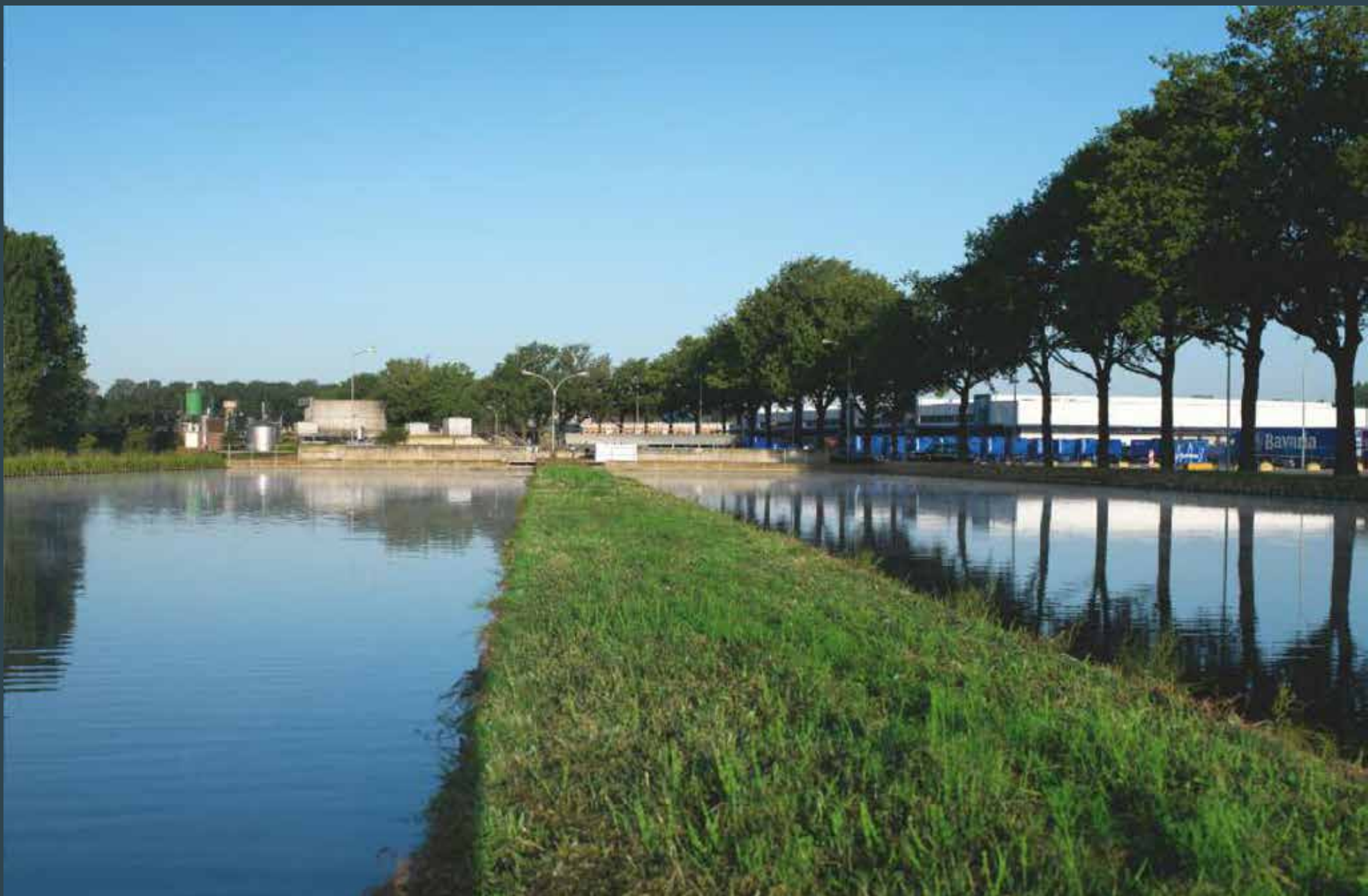
Waterzuiveringsinstallatie van Bavaria.
