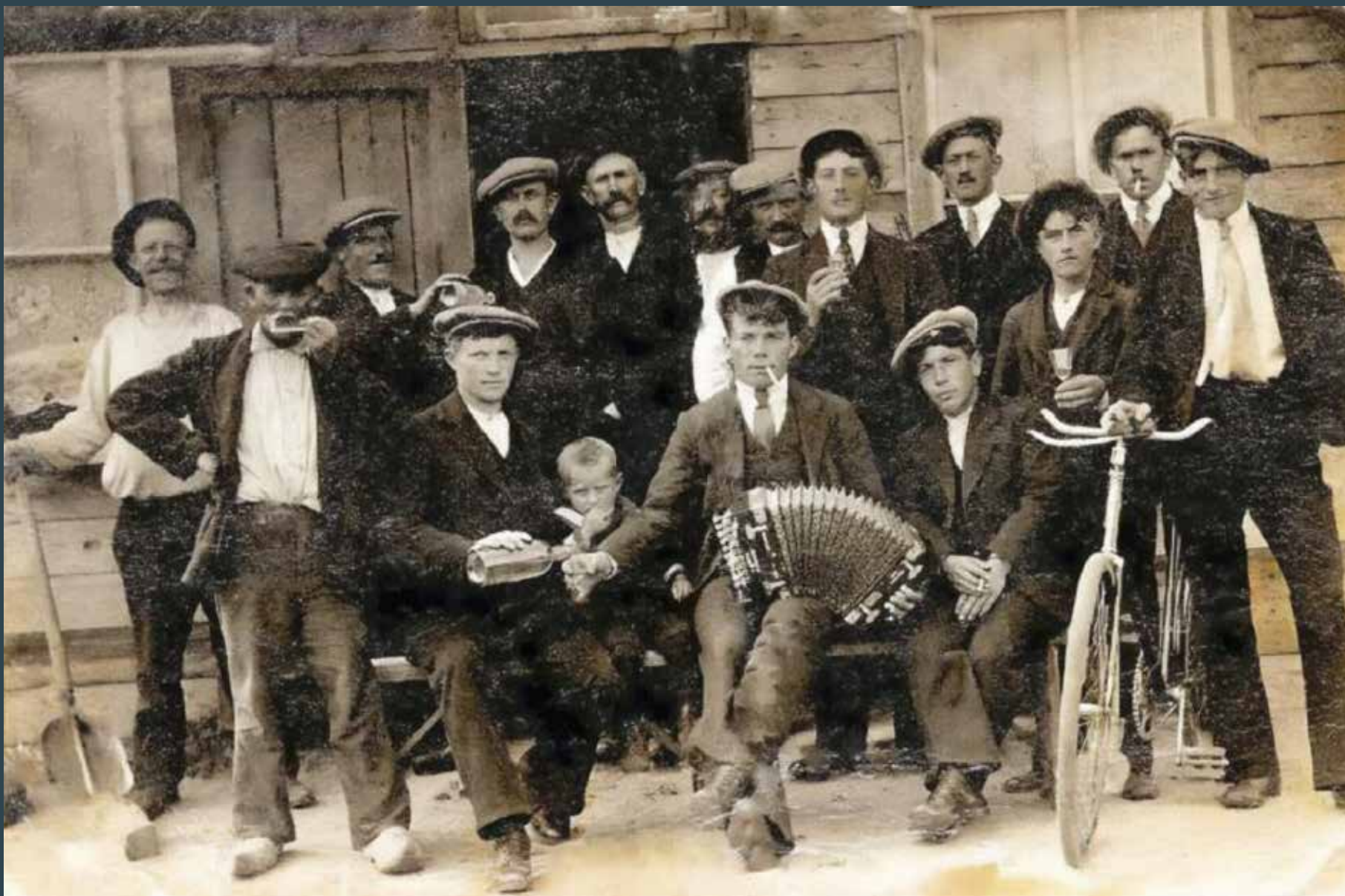
Sonse poldermannen vierden in 1923 feest bij gelegenheid van het gereedkomen van de werkzaamheden aan het kanaal.
