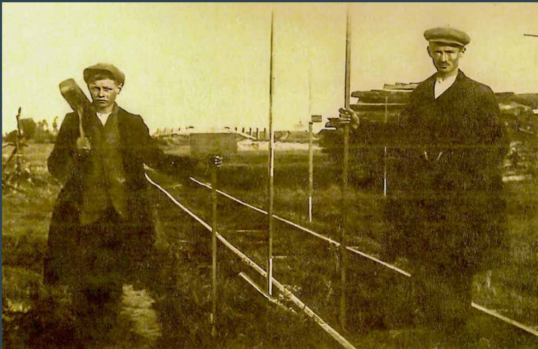
Een glasplaatfoto van Tinus de Köster (Swinkels) uit 1917. Rechts staat Coolen, die met een medewerker met een zichtplaat en hamer met piketten het peil uitzet.
