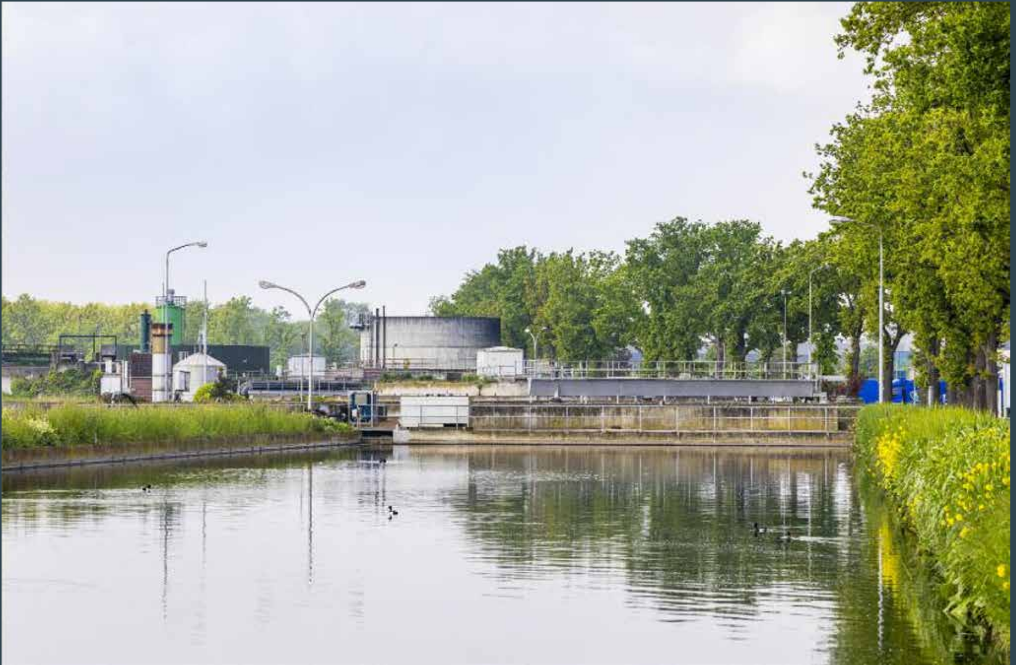
Waterzuiveringsinstallatie van Bavaria.
