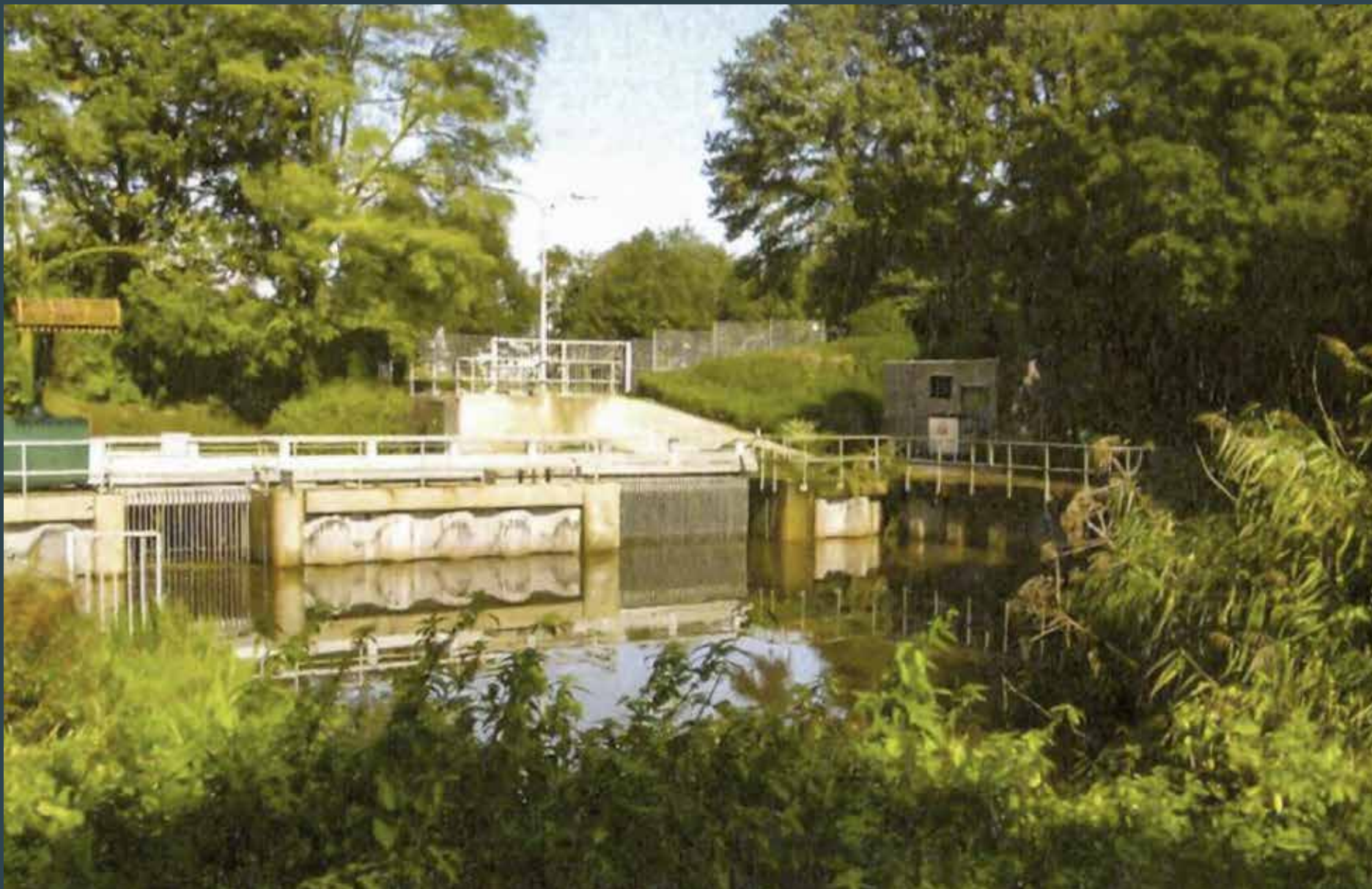
De huidige Goorloopduiker. Links de rakel die automatisch drijfhout en andere rommel opvist en rechts het pomphuis.
