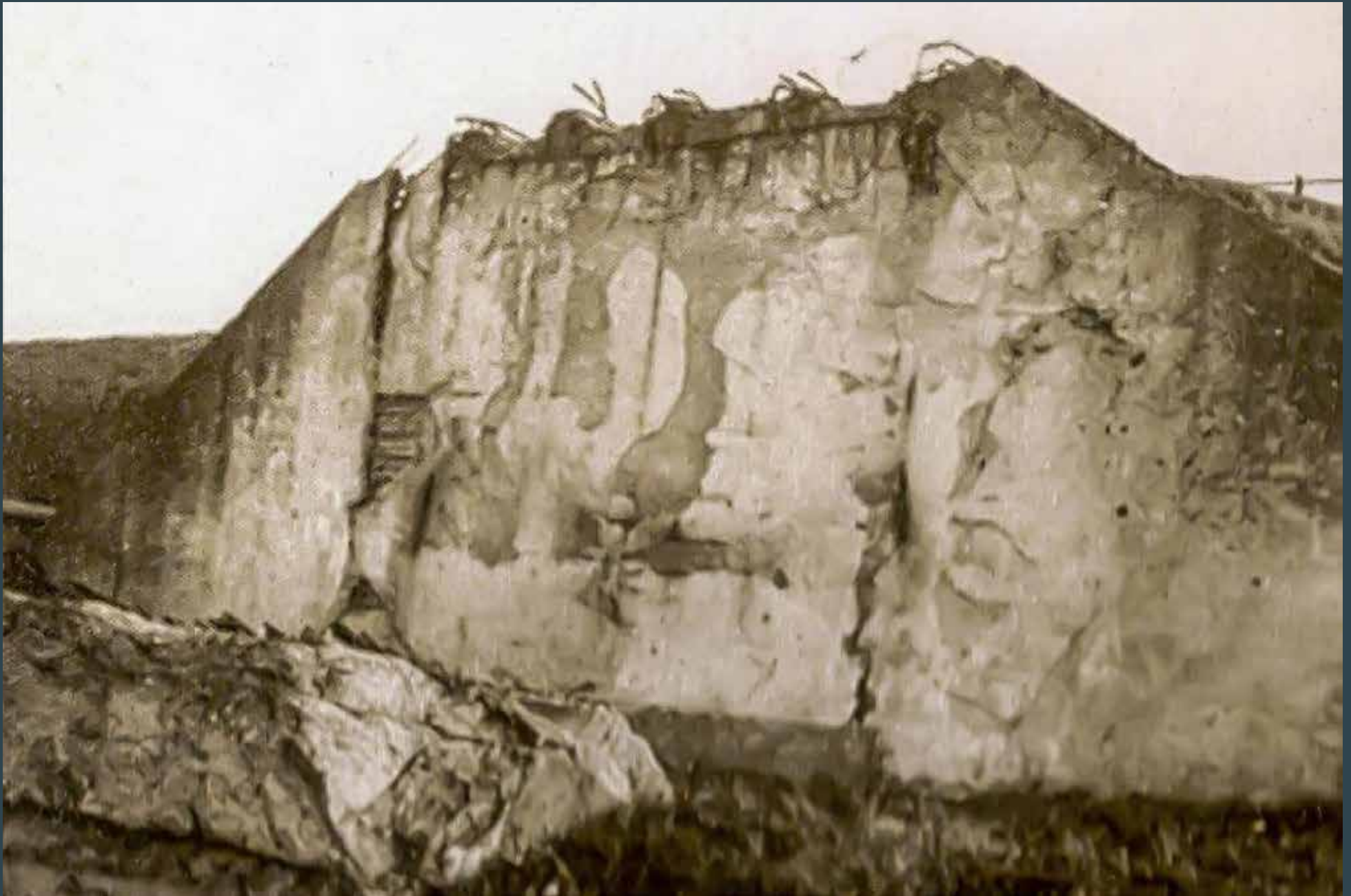
Restant van de opgeblazen Laarbrug.
