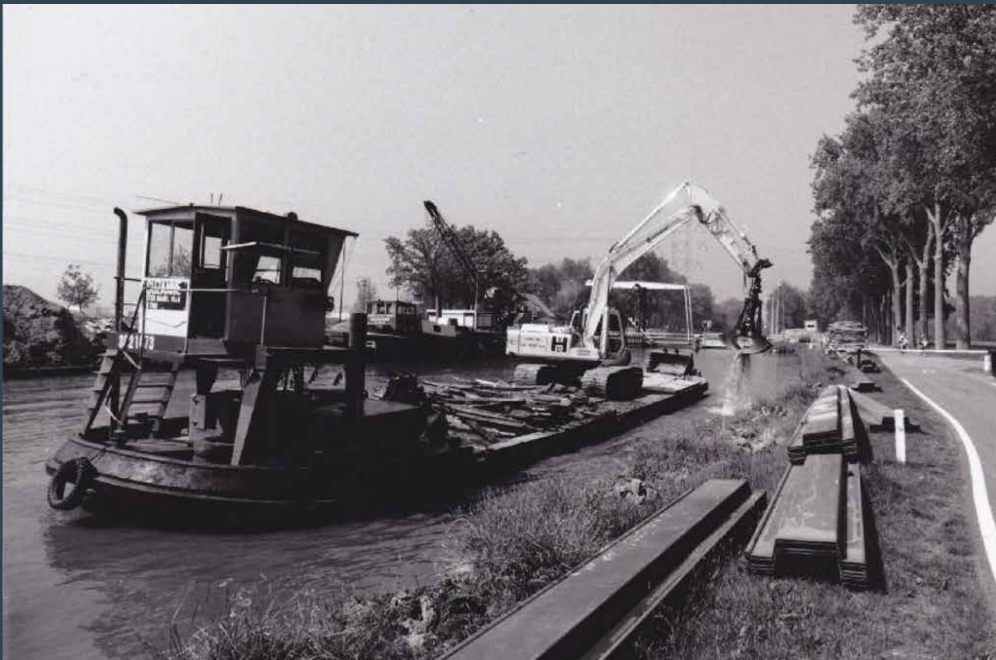
1993. Het plaatsen van een nieuwe damwand langs het Wilhelminakanaal in Son.
