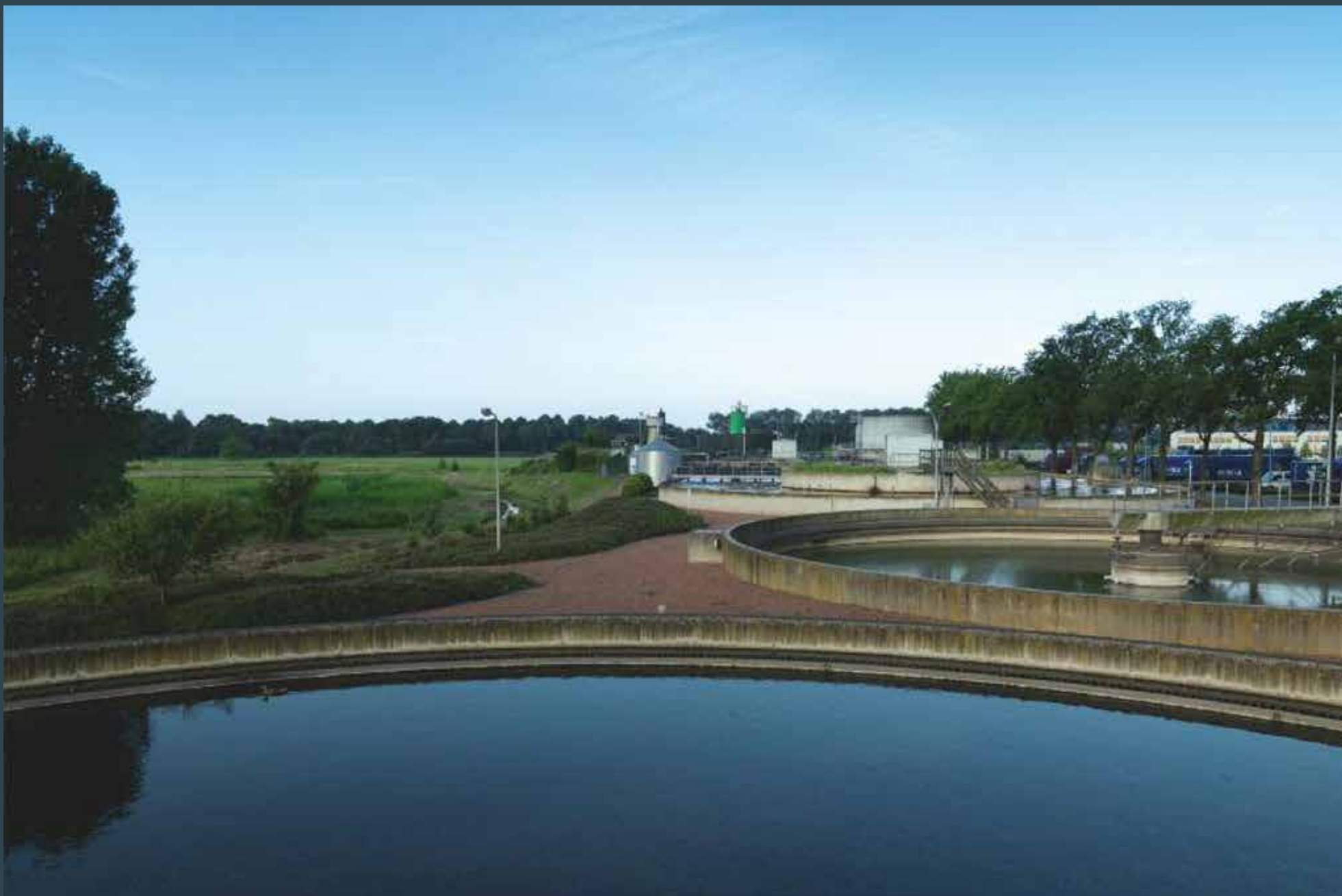
Waterzuiveringsinstallatie van Bavaria.
