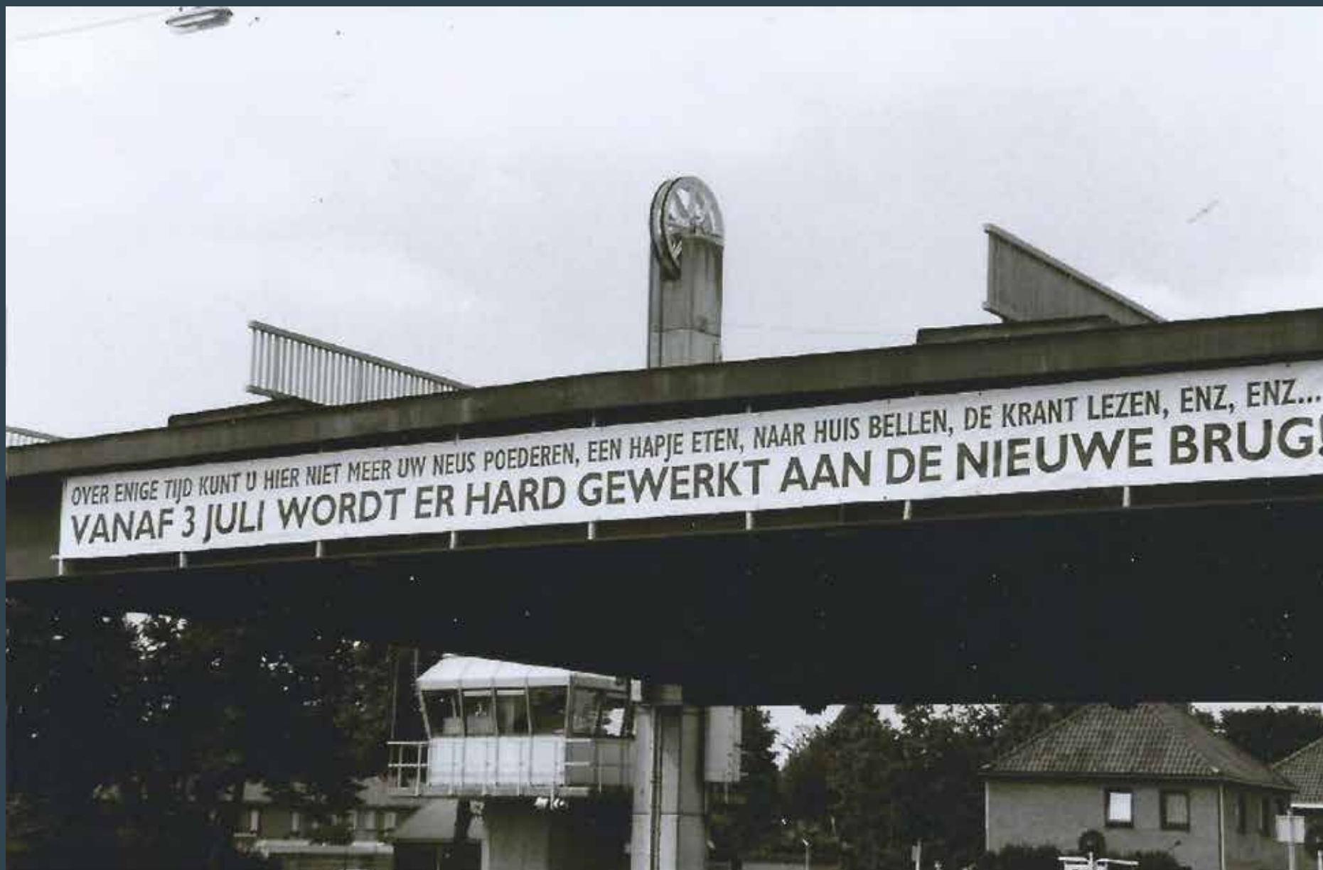
1980. Werkzaamheden aan de nieuwe hefbrug over het Wilhelminakanaal gezien vanaf de zuidzijde.
