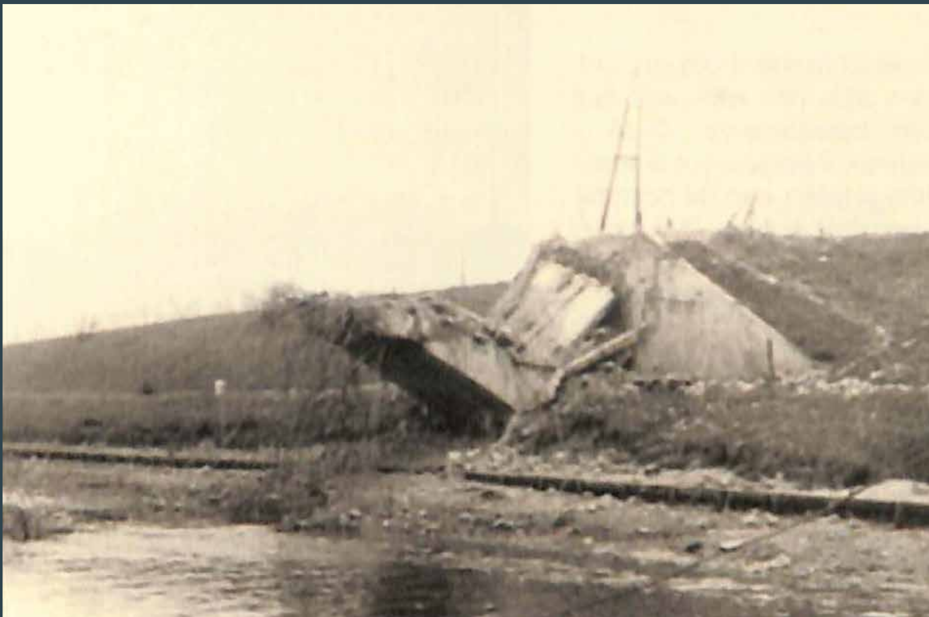
Restant van een vernielde boogbrug in 1940. Het kanaal was al gedeeltelijk leeggestroomd.
