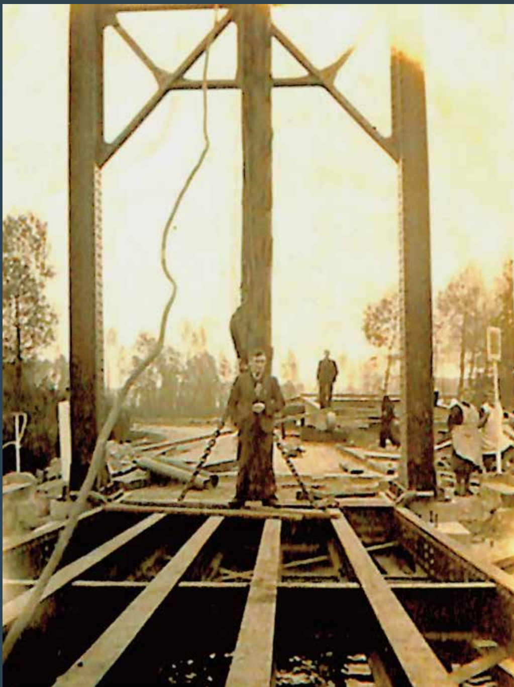
Reparatie van de brug van sluis V in 1945. In het midden Bert Cooijmans, de vrouw langs staander is Pieta Cooijmans.
