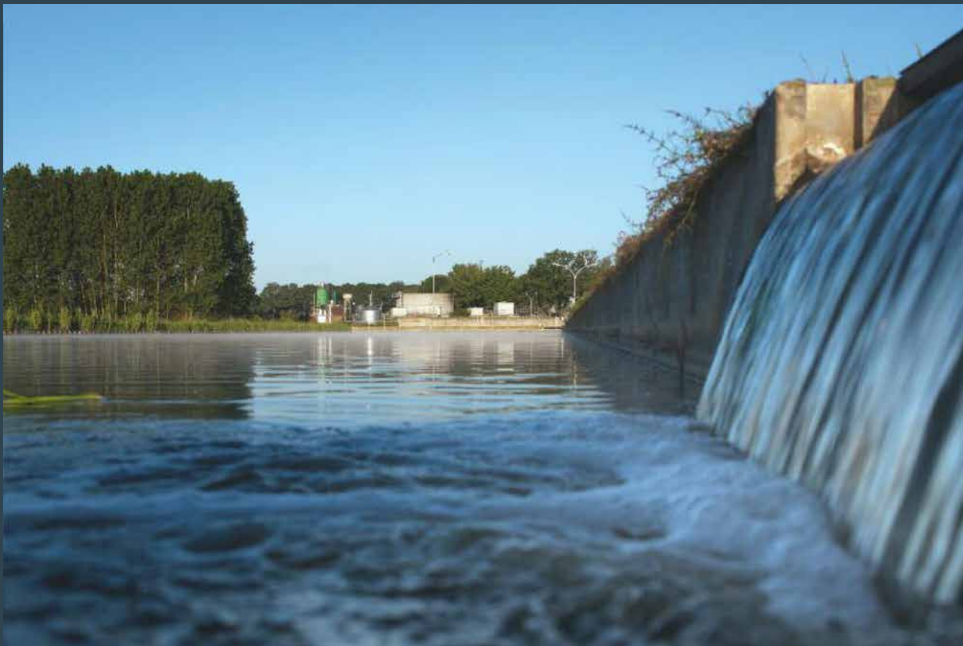
Waterzuiveringsinstallatie van Bavaria.
