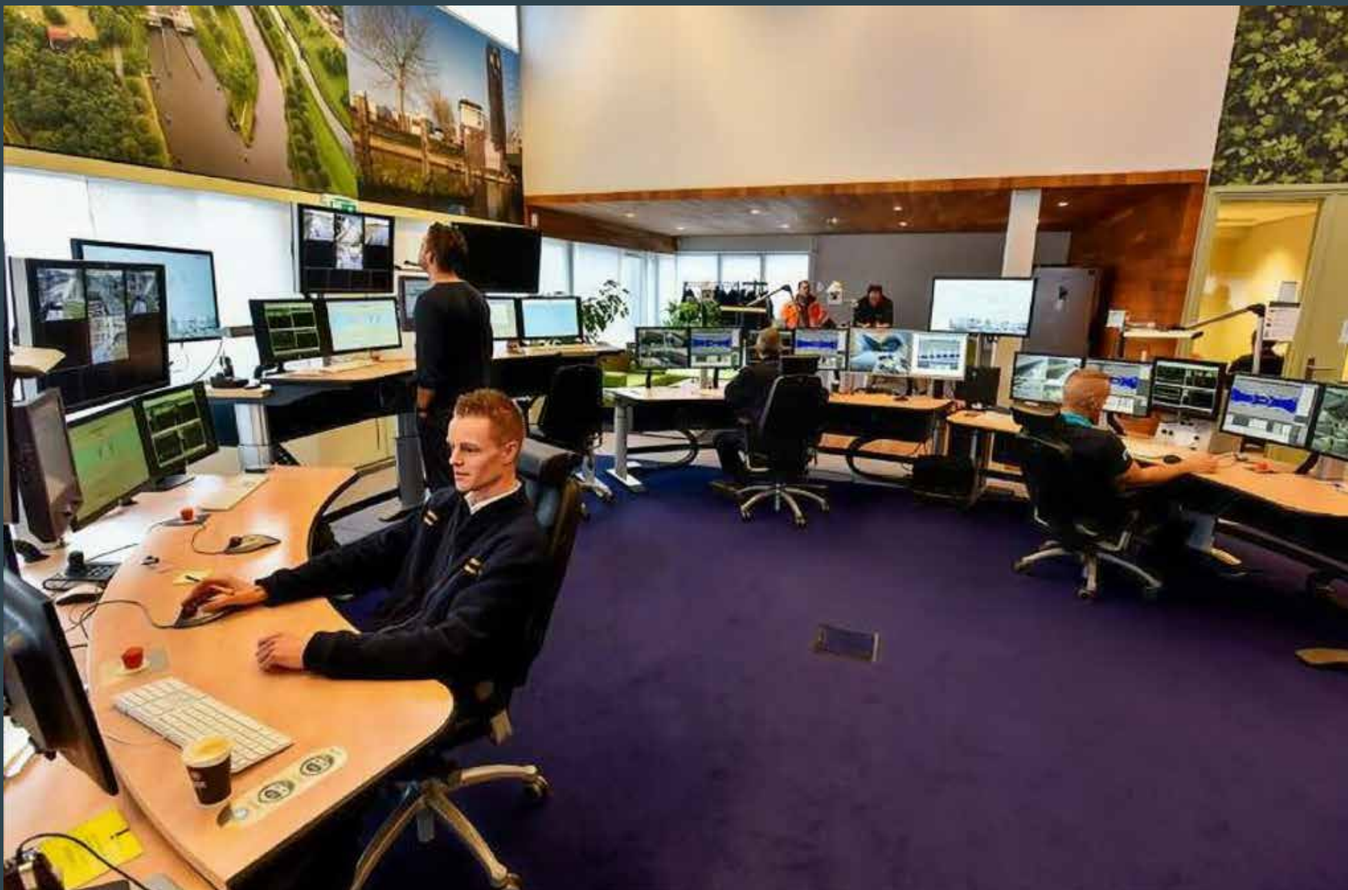
Centrale voor de bediening van de bruggen en sluizen op afstand.
